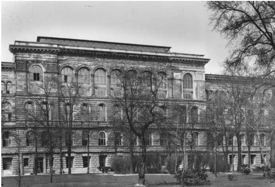
Die Bibliothek nimmt ihren alten Standort wieder im 2. Obergeschoss ein, hinter dessen horizontal geteilten Rundbogenfenstern sich der zweigeschossige Lesesaal befindet.
